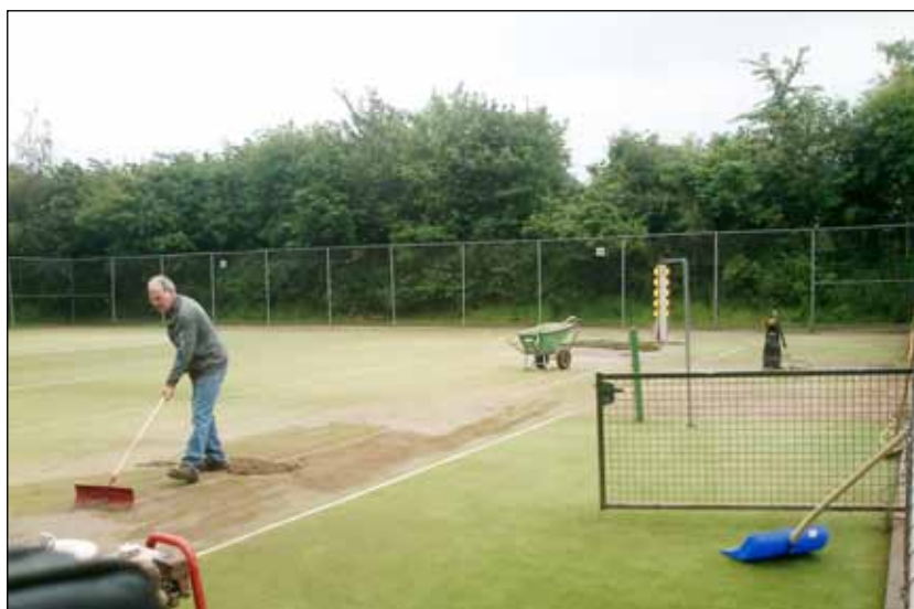
Groundsman Piet van der Vlugt tijdens een van de vele herstelwerkzaamheden op het park.
